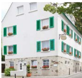
■ Gästehaus „Alte Schule“
